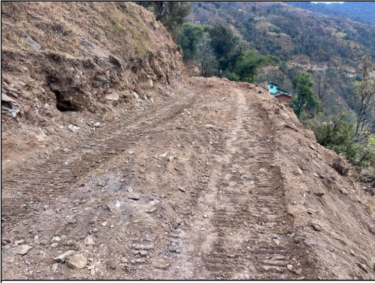
मालिकार्जुन न्वालपानी सडक नयाँ ट्रयाक निर्माण
